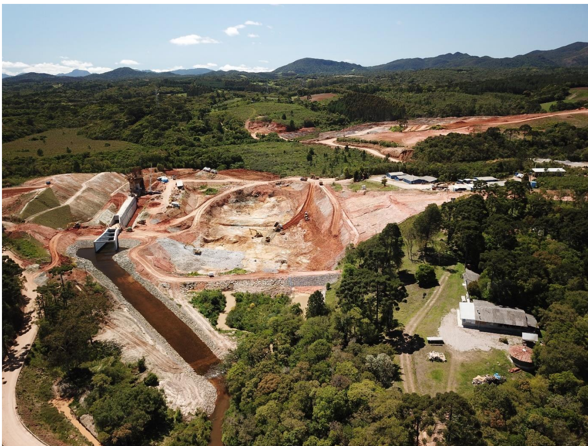
FIGURA 11 – VISÃO GERAL DO EMPREENDIMENTO
