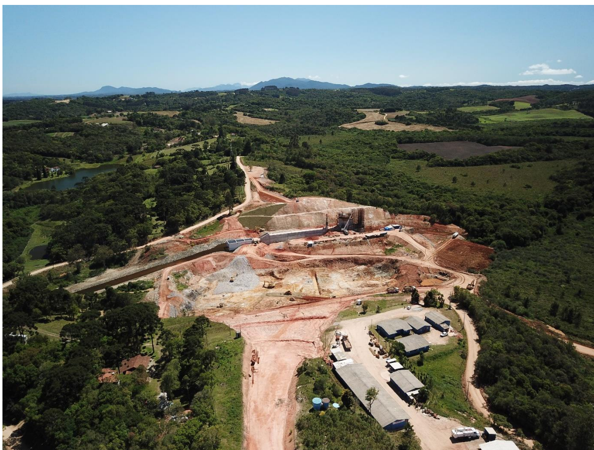
FIGURA 09 – VISÃO GERAL DO EMPREENDIMENTO
