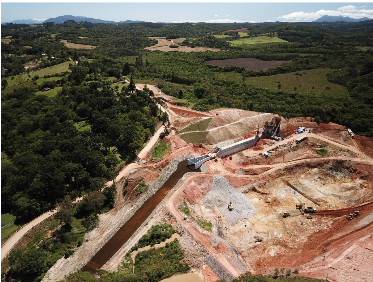
FIGURA 10 – VISÃO GERAL DO EMPREENDIMENTO
