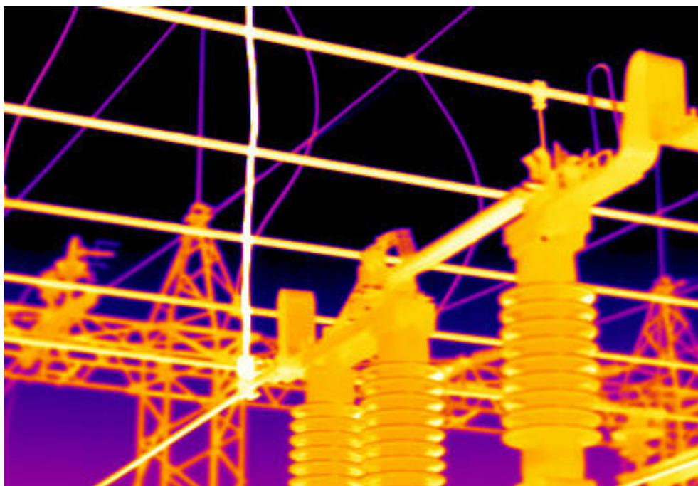
FIGURA 9 – TERMOGRAMA 9 – SUBESTAÇÃO MANDAGUAÇU (MCU)
