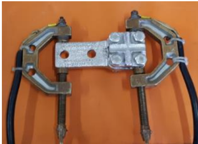
FIGURA 13 - MEDIÇÃO DE RESISTÊNCIA ELÉTRICA COM MICROOHMÍMETRO
