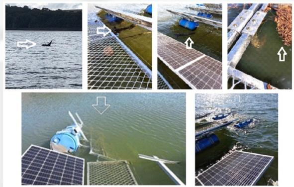
Figura 5: Fotos ilustrativas de parte dos problemas ocorridos durante uma forte chuva torrencial e elevação rápida de nível do reservatório, na IFVF SC. As setas ilustram a presença de troncos arrastados contra a ilha e os problemas de afundamentos constatados.
