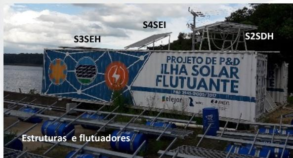
Figura 2: Sistemas fotovoltaicos instalados em solo e estrutura flutuante patenteada (INPI-BR-10-2018-010821-2) [27] [28], com uso em S1FEI no reservatório da UHE Santa Clara.
